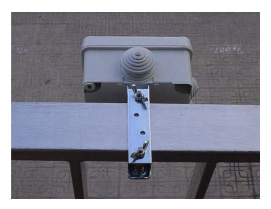
Observar que la caja queda unos centímetros separada hacia fuera de la fachada a merced de la circulación de aire de la calle, evitando el aire estancado del interior del balcón.
